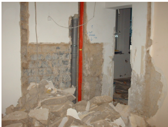
Umbaumaßnahmen im Erdgeschoss der Hochstr.83
